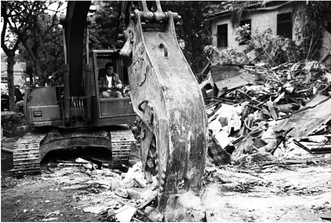
（圖說：2011，台北市萬隆一帶，某個正在進行拆除作業的都更案，不願參與都更的地主正在怪手後方向媒體求助。）
