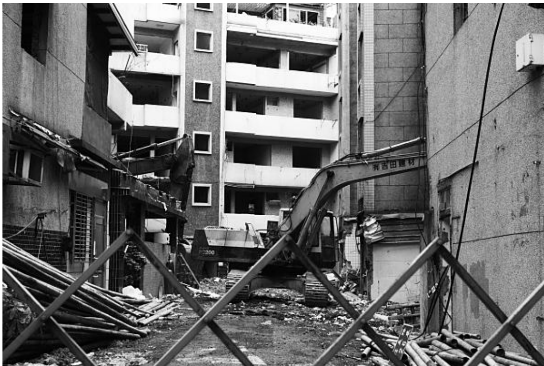
（圖說：2010，新北市永和區，某個已經清空，正在進行拆除作業的都更案。）
